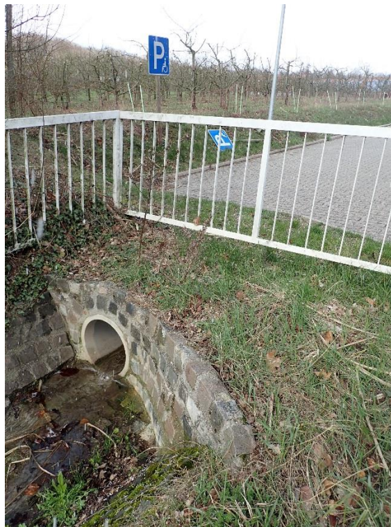
Abbildung 7: Erfassung relevanter Gewässerläufe. Hier Verdolung am Wintringer Hof westlich von Bliesransbach
