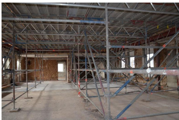
Blick in das Dachgeschoss
