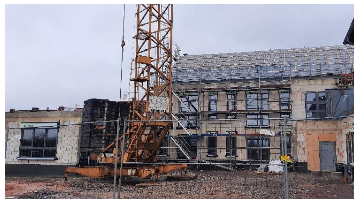
Rückseitige Ansicht des Gebäudes
