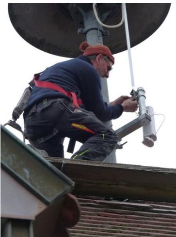
Dachdeckermeister Michael Limbach bei der Installation des Gateways auf dem Rathausdach;
