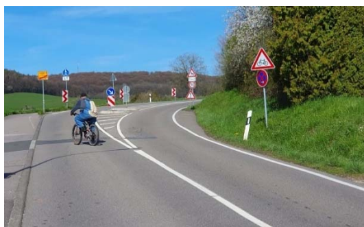
Fehlende Anbindung der Querungsstelle im Radzielnetz (Bliesransbach)
