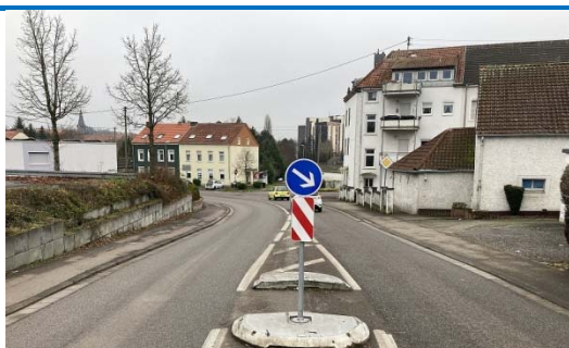
Nicht für Radverkehr geeignete Mittelinsel als Querungsstelle ohne Beleuchtung
