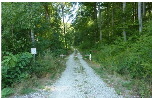
Nicht geöffnete Schranke mit schlechter Umfahrbarkeit
