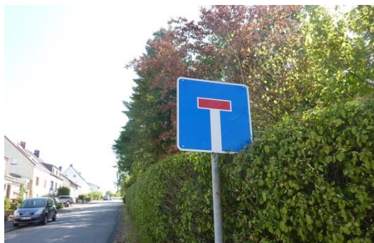
Fehlende Kennzeichnung der möglichen Durchfahrt am Ende der Sackgasse
