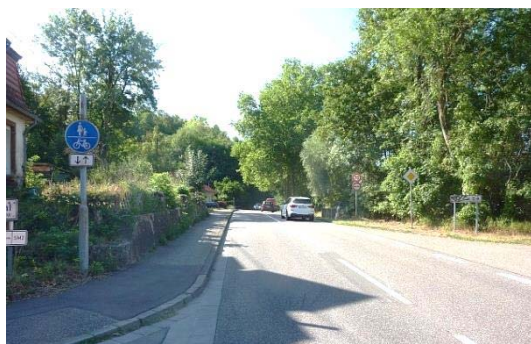
Problematische Zweirichtungsradführung in einer baulichen Engstelle an der B 51
