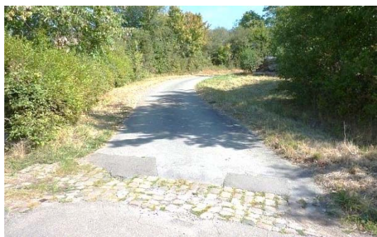
Nicht radgeeignete Entwässerungsrinnen der Feldwegverbindung Auersmacher
